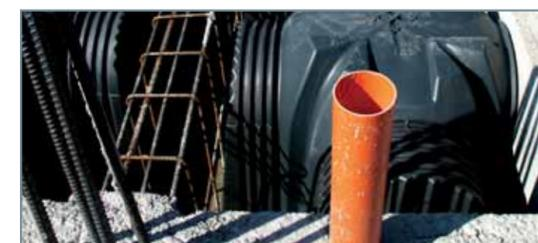
Пример установки вентиляционных труб сквозь балки основания для соединения секций плиты
